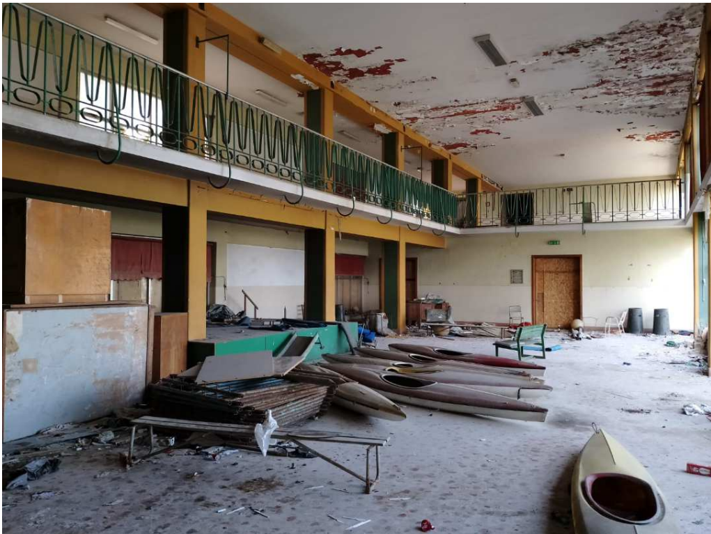
Interno: il piano terra della struttura principale, il refettorio con il doppio volume, foto ottobre2023
