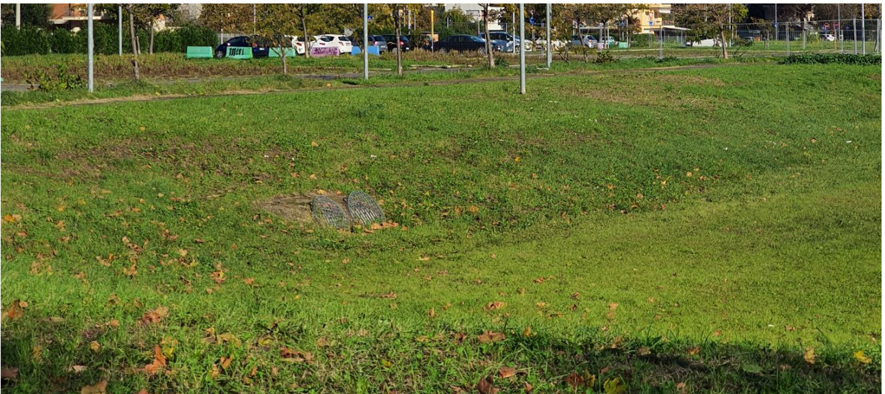
L'uscita del sistema di mandata dell'acqua piovra
