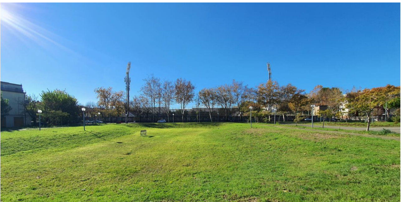
Figura 8. Vista dell'area di intervento con in primo piano la vasca di laminazione e sullo sfondo lo stadio
